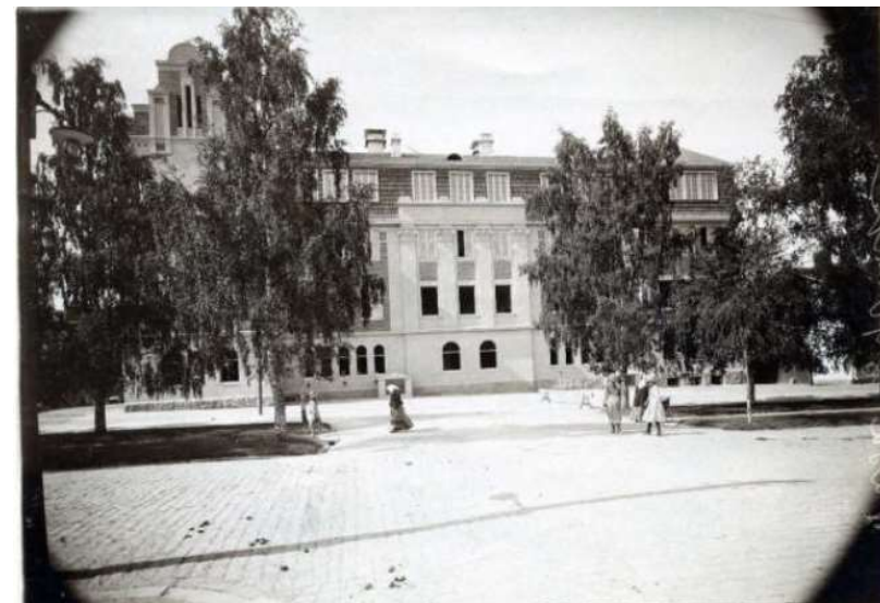
Kauppapuistikko 22 rakennusvaiheessa, kuva: Pohjanmaan museon arkisto
